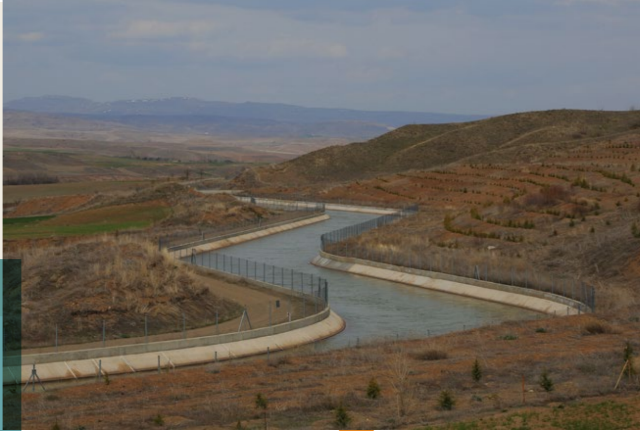
Fotoğraf 9: Sivas Saraçbendi HES Kanal Güzergahı Rehabilitasyonu-1
