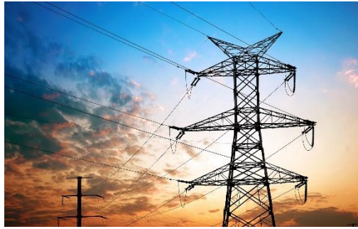
Şekil 1 : Rüzgar Türbinleri, Enerji Hatları ve Şalt Sahası Örnek Fotoğrafları
