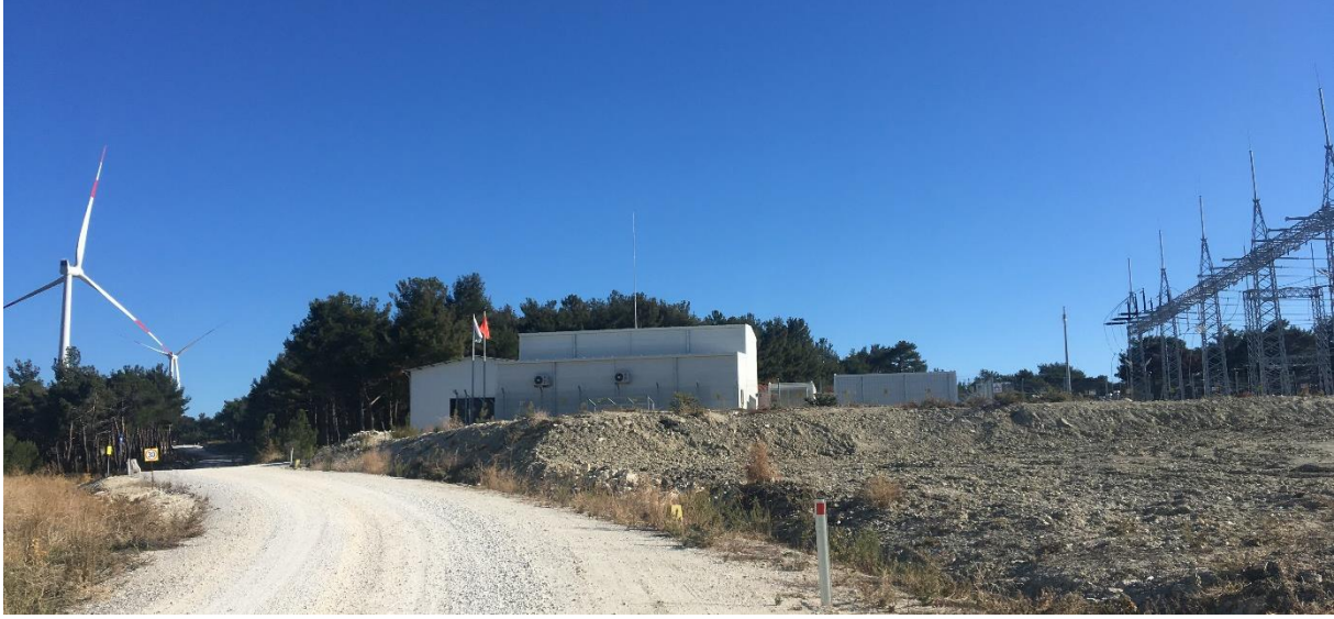
Şekil 9 : Mevcut Şalt Sahası/İdari Binadan Görünüm
