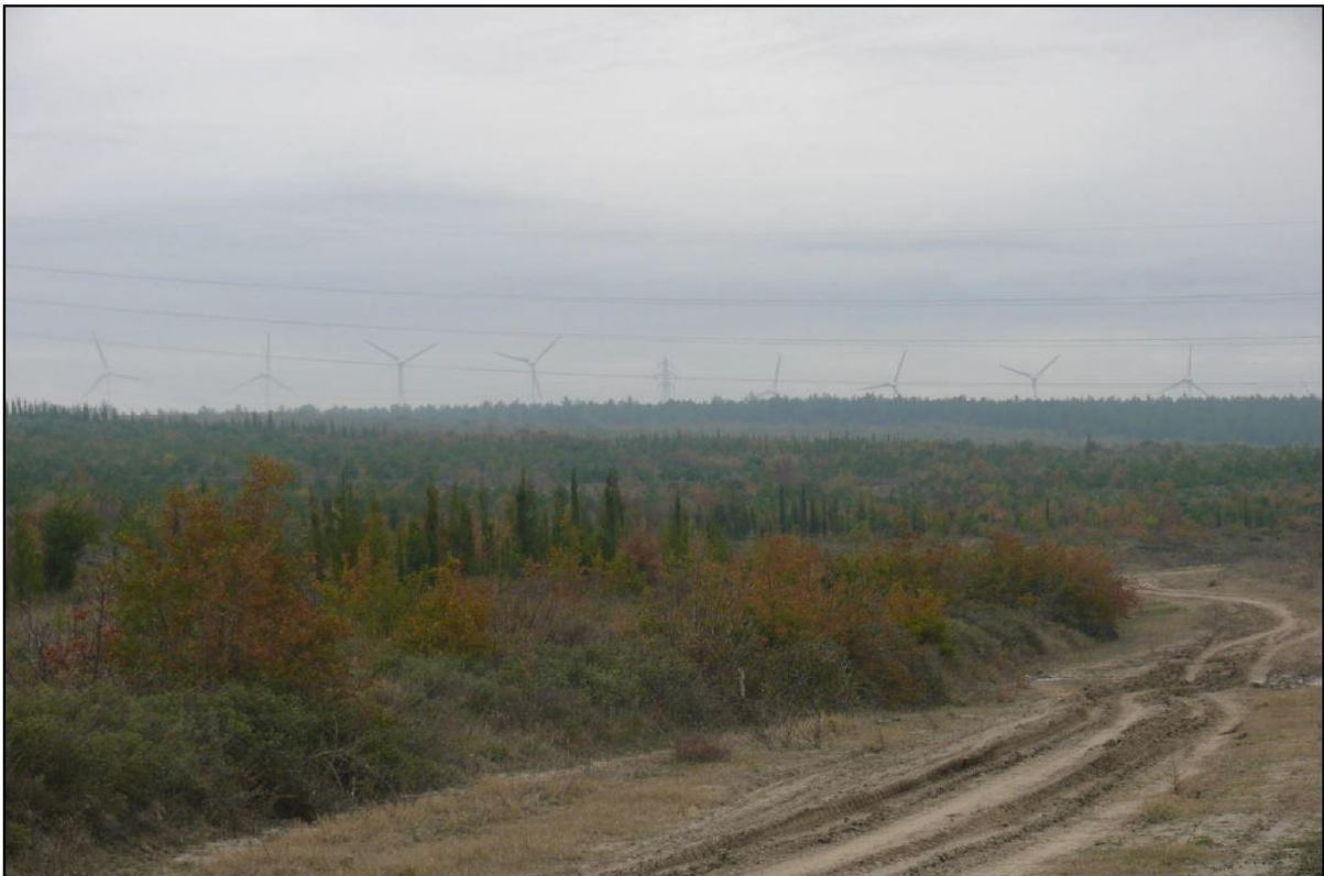
Şekil 13 : Proje Alanının Yaklaşık 1,5 km Kuzey-Kuzeybatısındaki İntepe RES Türbinleri
