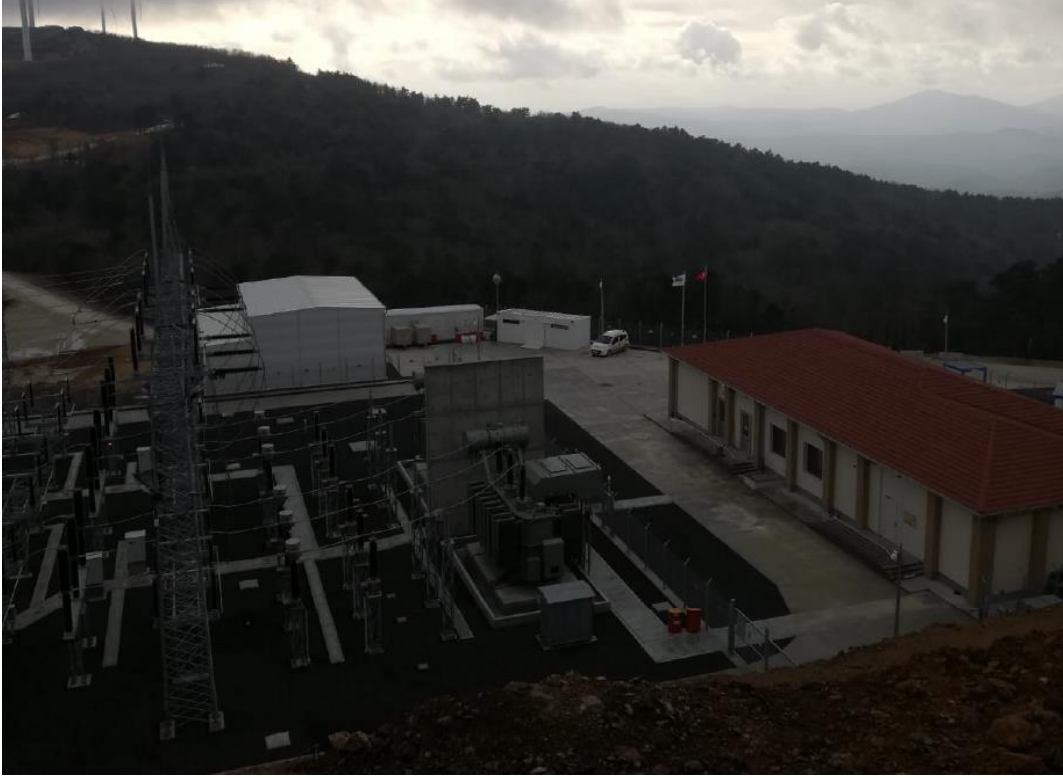
Şekil 12 : Mevcut Şalt Sahası/İdari Binadan Görünüm
