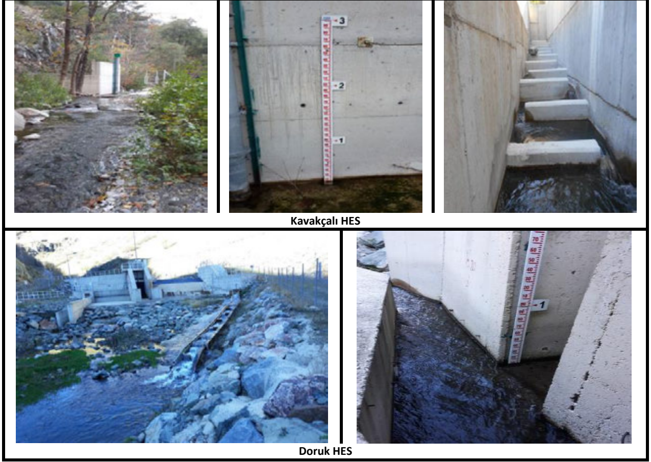
Fotoğraf 27- HES'lerde Örnek Balık Geçidi ve AGİ Uygulamaları
