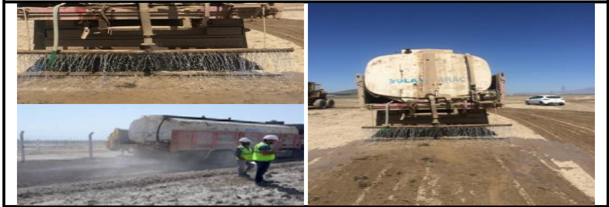
Fotoğraf 23 : İnşaat Çalışmalarında Alınan Toz Önleyici Tedbirlere Ait Uygulamalar
