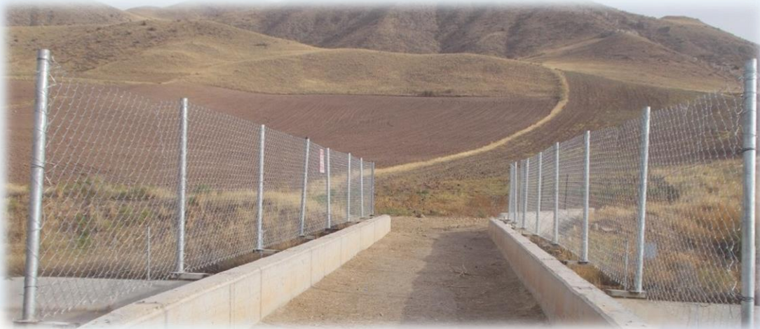
Saraçbendi HES İletim Kanalı Fauna Geçiş Yapıları
