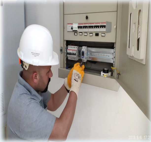
Çamlıca III HES Elektronik pano bakımı
