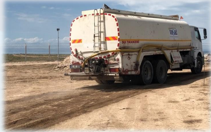
Fotoğraf 95- İnşaat Çalışmalarında Alınan Toz Önleyici Tedbirlere Ait Uygulamalar
