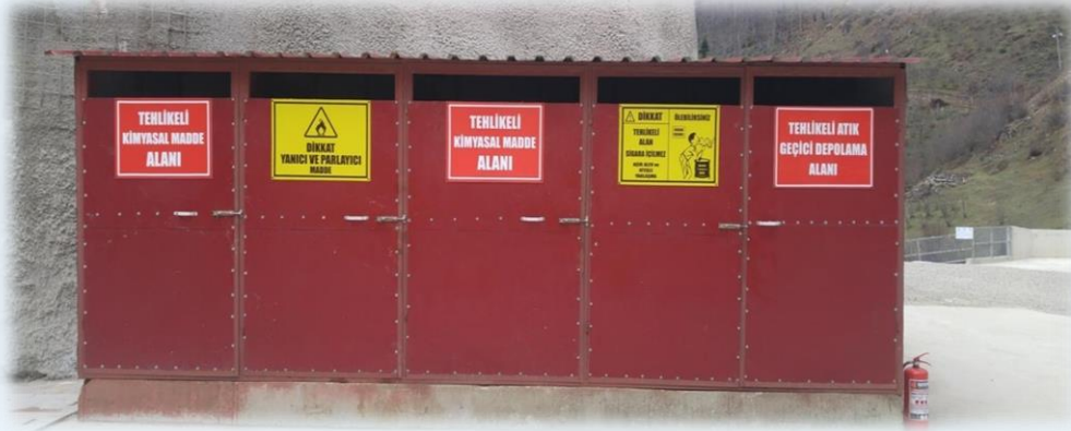
Çalıkobası HES Geçici Atık Depolama Alanı
