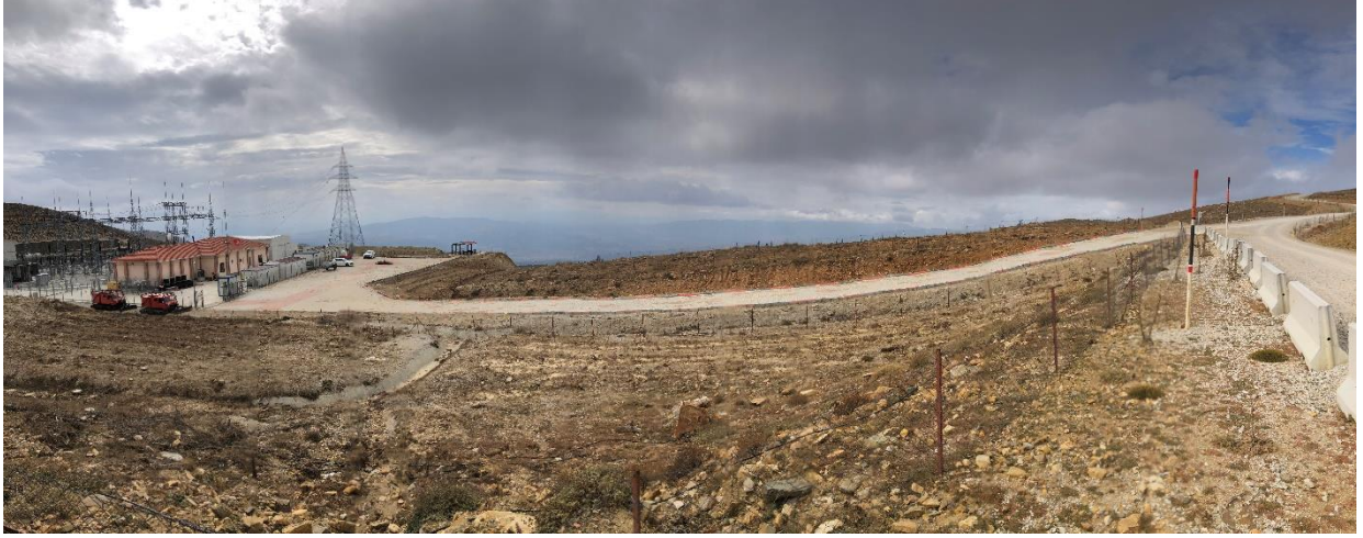
Resim 39. DENİZLİ RES SAHASI PEYZAJ VE REHABİLİTASYON ÇALIŞMALARI
