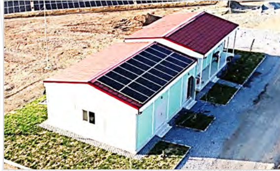
Resim 128 IOTA M. FIRINCI GES Çatı Üstü Fotovoltaik Paneller
