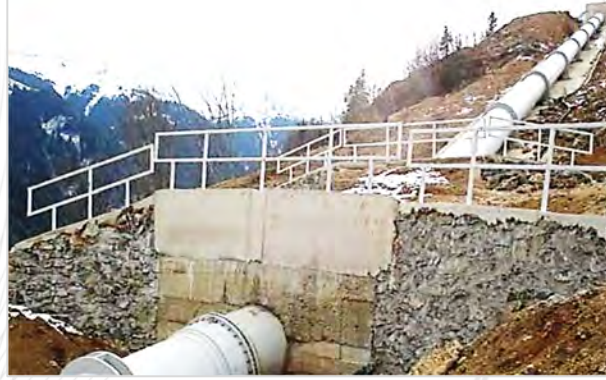
Resim 201 DEMİRCİLER HES İLETİM KANALI FAUNA GEÇİŞİ
